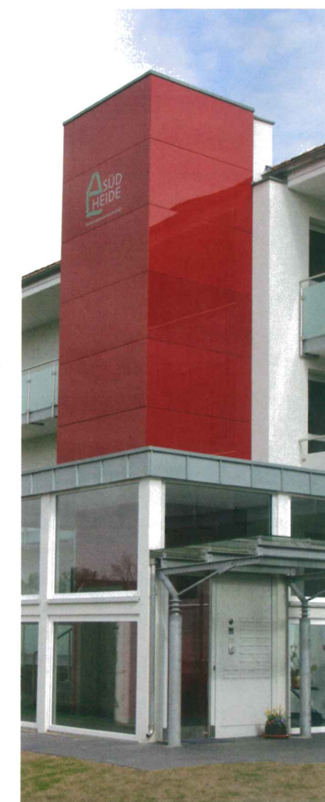
Wohnen ohne Barrieren: Der neue Aufzugturm.
